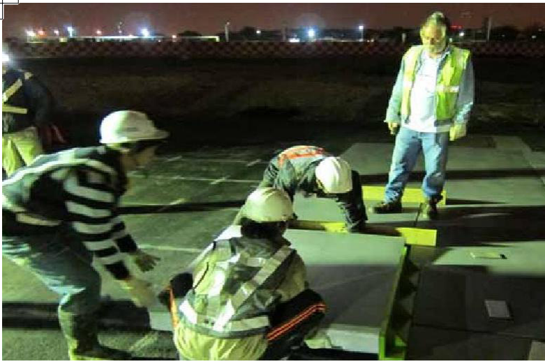
▲松山機場於深夜因噪音管制停止起降時，EMAS深夜施工安裝擋塊。 ▶世界台灣小姐Karena出席總統府之國慶典禮。
